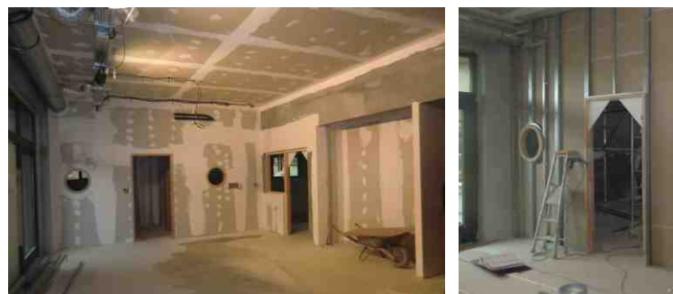
Pose des cloisons, menuiserie,
