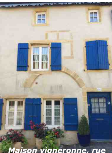
Maison vigneronne, rue du Général de Gaulle
