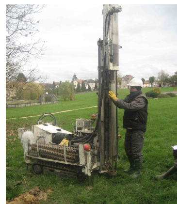
Sondage du sol sur le lieu d'implantation de la future structure multi-accueil
