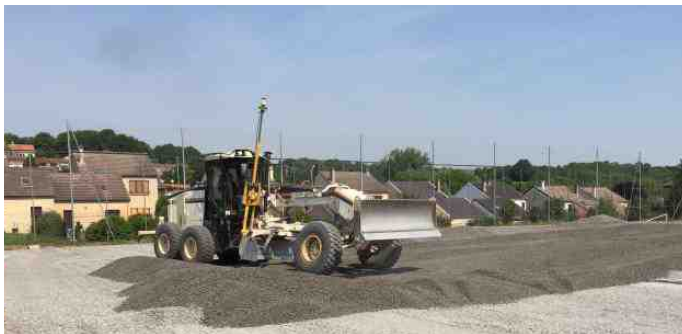
réglage à la niveleuse de la couche drainante (le réglage de la lame est asservi à des capteurs GPS)
